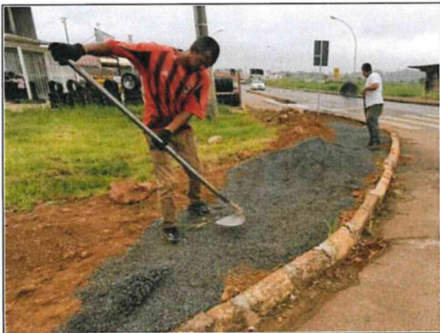
RECUPERAÇÃO ESTRADA RURAL CAUB I e II
